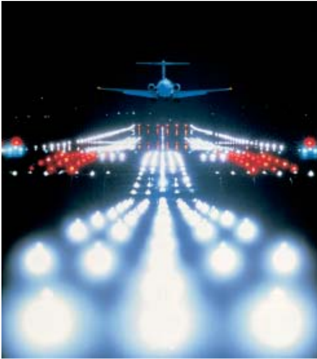
Licht schafft Sicherheit, Beispiel Flugfeldbeleuchtung (Foto: Osram)
